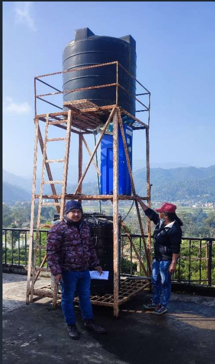
Foto: Ingenieur Milan Wagle neben PAUL auf Dach. Das Wasser fließt von dem oberen Tank durch PAUL In den unteren Tank und wird dabei gefiltert.
